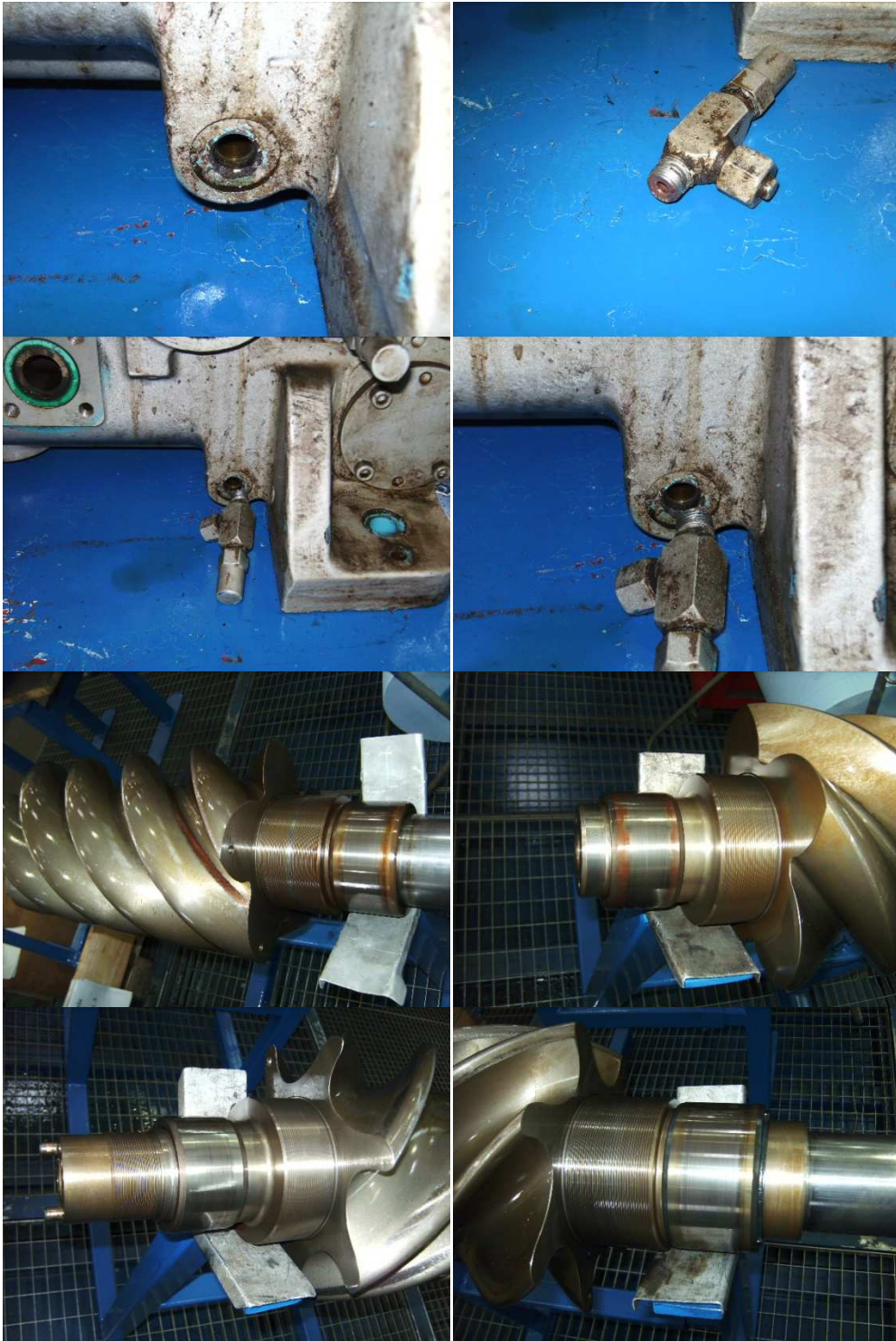
REVISIONE COMPRESSORE SABROE S 85
